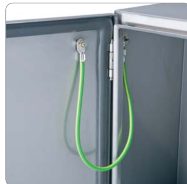
Болты заземления, приваренные к корпусу и двери
